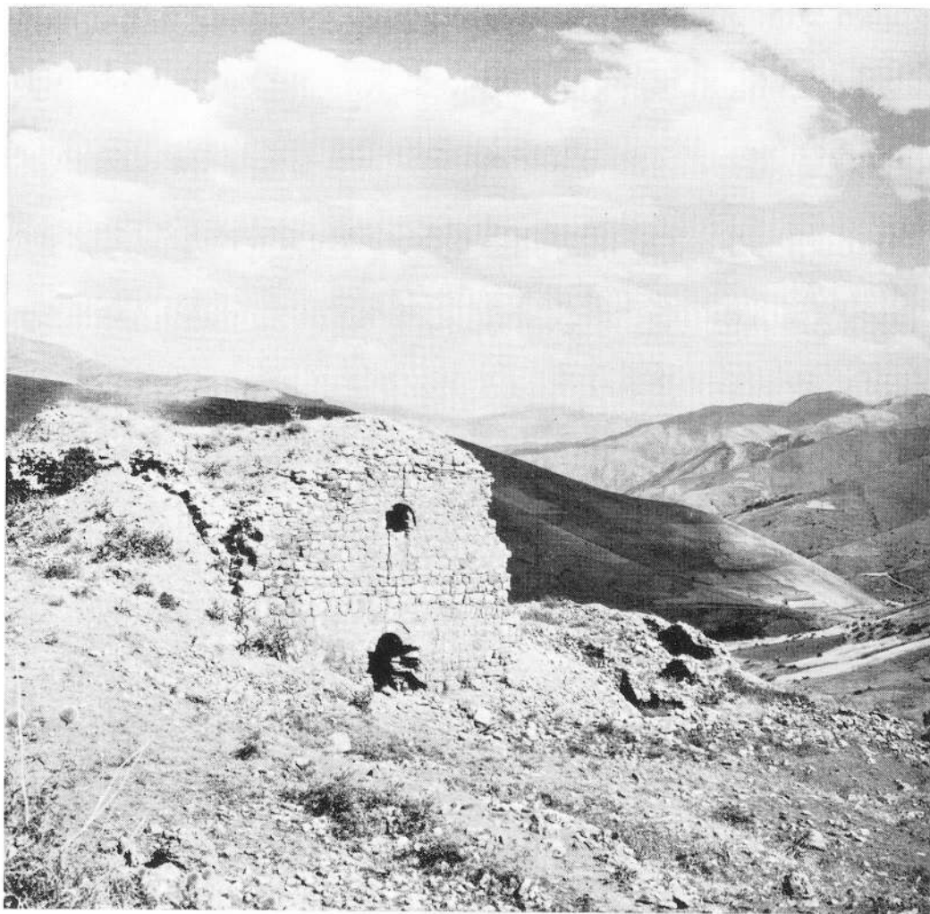
Fig. 15 — Église de Surb Hakob, au sud du lac de Van.
