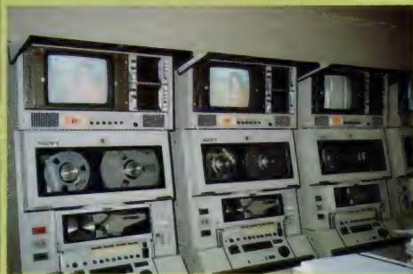
◆最新の設備を備えた放送局制作棟で収録された授業（テレビ番組、ラジオ番組）は、ここから東京タワーへ送られ、各地に電波で放送される。まさに放送大学の中核といったところで、電子ロックの扉を開けて中へ入る。
